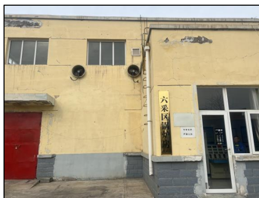
六采区锅炉房
