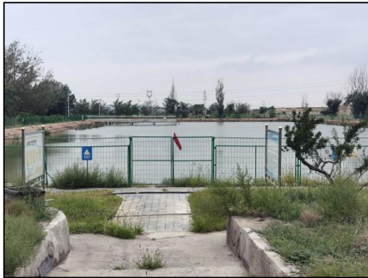
生活污水处理站蓄水池
